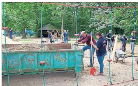
Tonnenweise Sand wurde an der Vinzenz-von-Paul-Schule in Beckum ausgetauscht.
