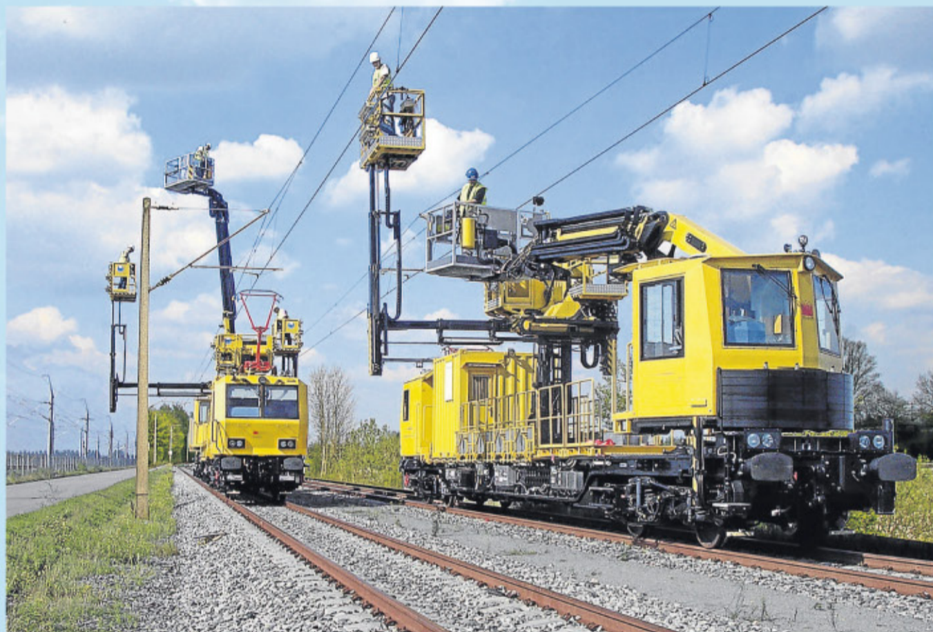
Wartungsfahrzeuge für Bahn-Oberleitungen im typischen Gelb im Einsatz.
